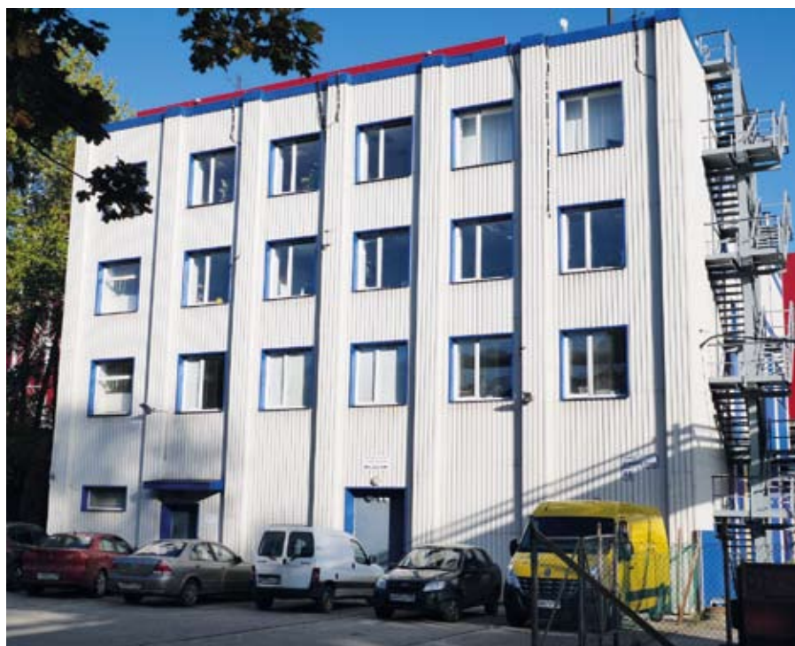
Производственное здание ООО «Биотроф»
