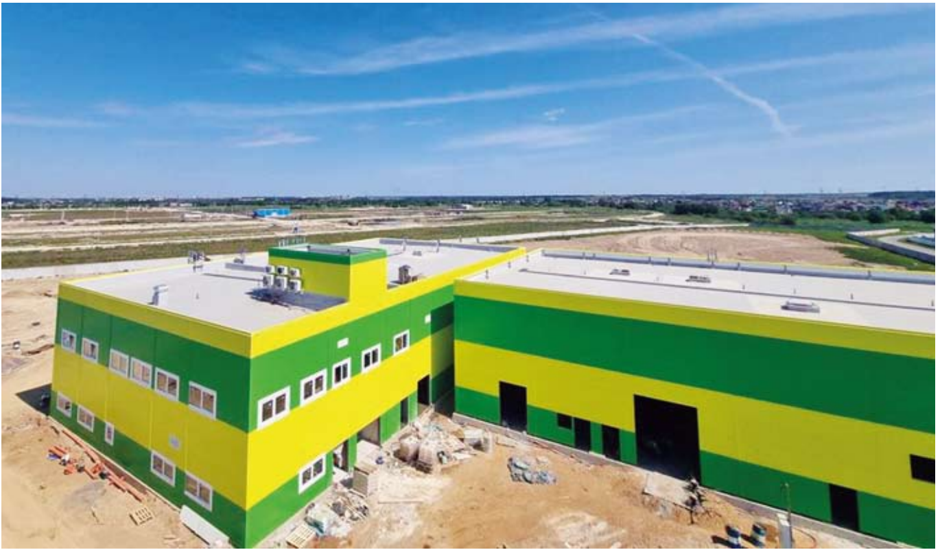
Строительство новых производственных корпусов в поселке Федоровское Ленинградской области
